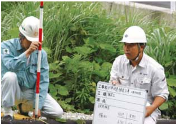
現場の検査風景
